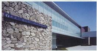
↑水光会 総合リハ・フィットネスセンター(敷地面積約1万4,000㎡、鉄筋コンクリート2階建て、延べ床面積約4,400㎡)。同グループの有料老人ホームと高専責に直結している
